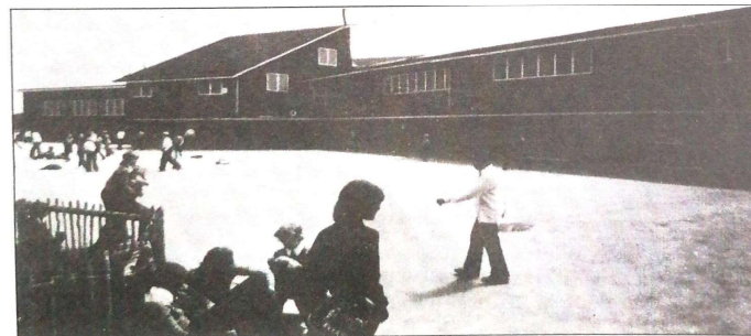
تصویر ۱۲-۲. نمای شفاف جنوبی، نمای نسبتاً بسته شمالی و بام با شیب یک طرفه در دبیرستان سنت جورج، با توجه به عملکرد بنا و اقلیم نسبتاً سرد و مرطوب شهر والاسی در ساحل غربی انگلستان طراحی شده است (Mazria, 1979: 31).
