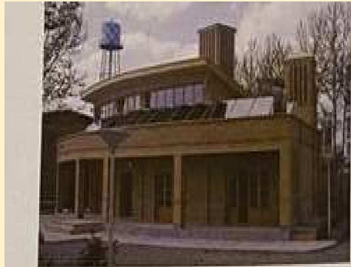
ساختمان خورشیدی در مقابل آفتاب جنوب گسترش پیدا کرده و سه ضلع دیگر آن نسبتاً بسته است. (ماخذ: نگارنده)
