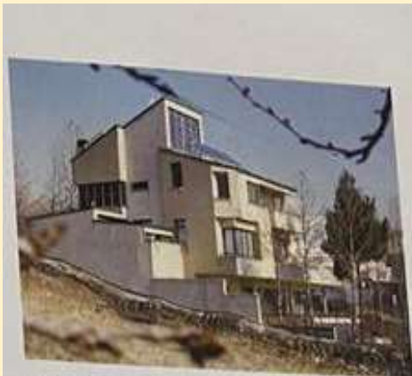
در طرح خانه لواسان، ضلع جنوب شفاف و سه ضلع دیگر ساختمان نسبتاً بسته و در پوشش خاک قرار گرفته است. (مآخذ: نگارنده)
